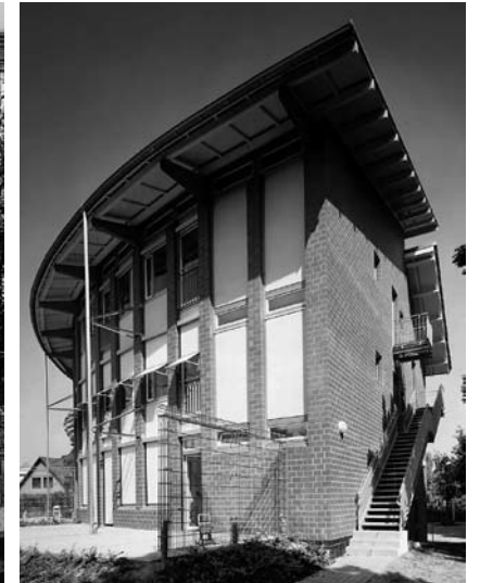
Neubau Kindertagesstätte Lichtenrader Damm 190, Tempelhof, 1997
