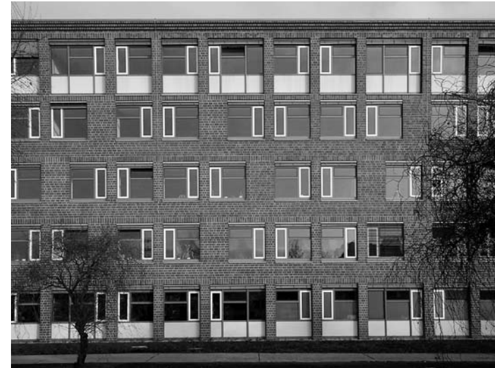
Erweiterung und Sanierung OSZ Handel II, Marzahner Chaussee 231, 2004
